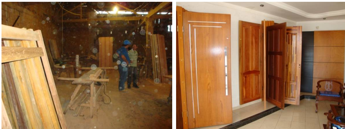
Imagem 13 e 14 – Empresa MADEIRA BELLA - sector de fabricação e exposição de portas no showroom
