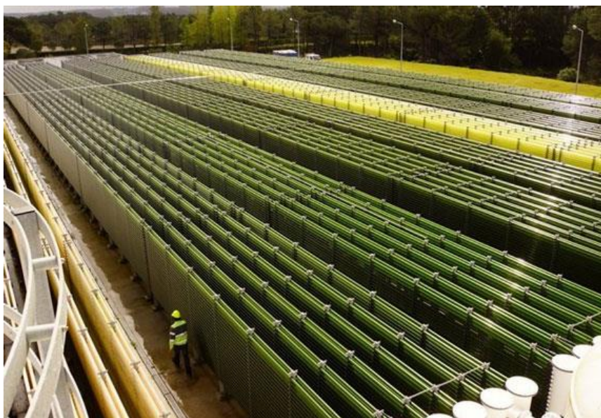
Figura 28. Fotografia parcial das instalações da empresa A4F localizada em Pataias, Portugal.
