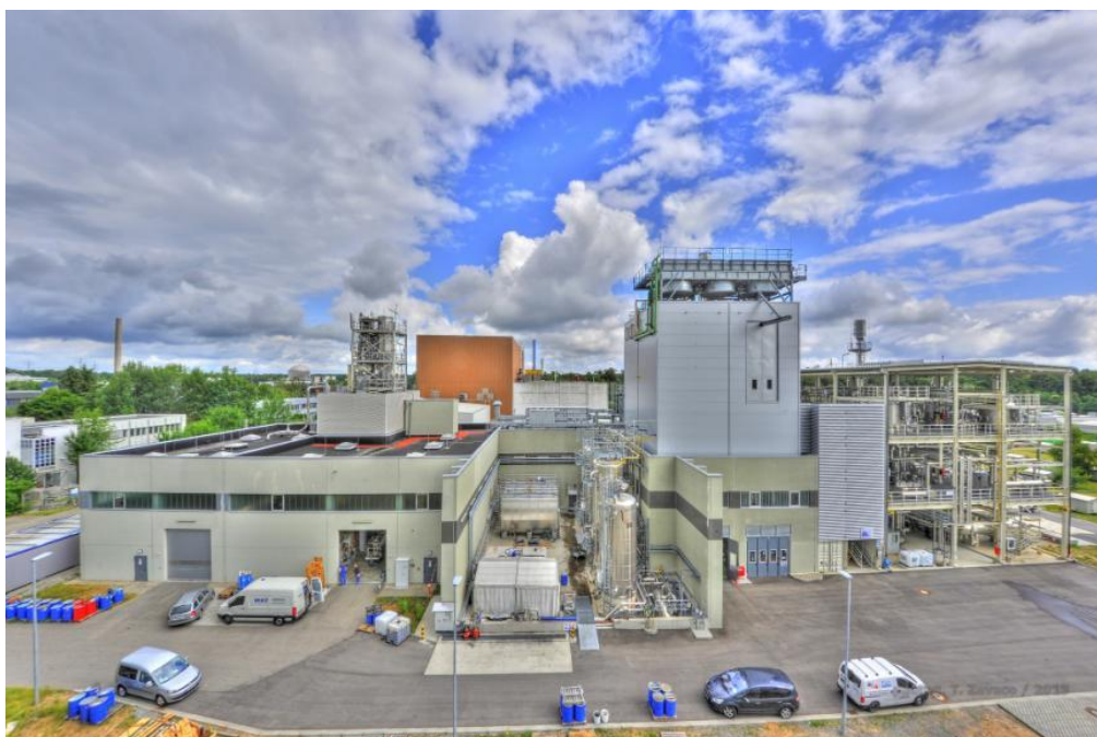
Figura 47. Foto da instalação piloto em Karlsruhe na Alemanha.
