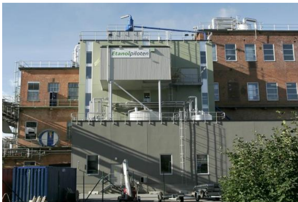
Figura 24. Fotografia da fábrica demo da companhia SEKAB localizada em Örnköldsvik, Suécia.
