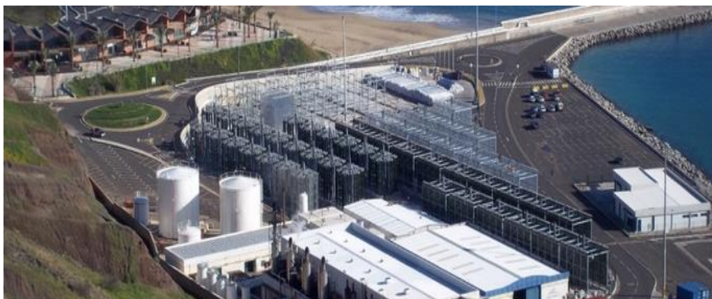
Figura 31. Fotografia das instalações da empresa Buggypower S. L localizada em Porto Santo, Portugal.
