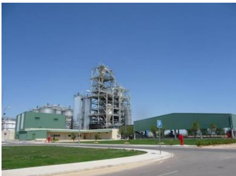
Figura 3. Fotografia da fábrica demo da empresa Abengoa Bioenergy em Babilafuente, Espanha.
