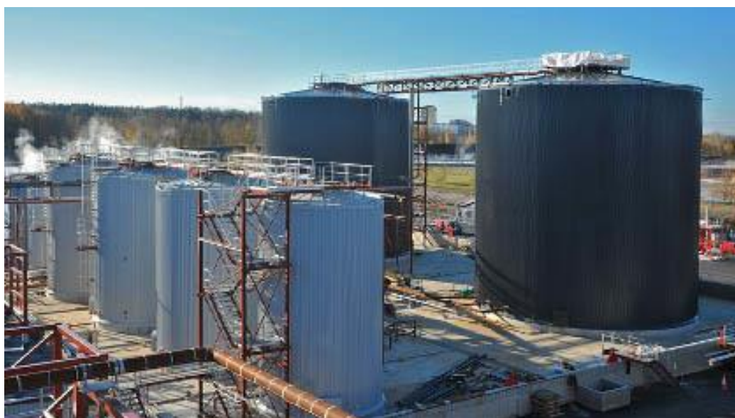
Figura 52. Panorâmica da instalação de biorrefinaria em construção pela UPM em Lappeenranta na Finlândia.
